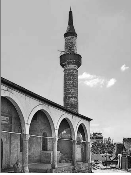
Aşağı Develi Ulucamii – Kayseri
